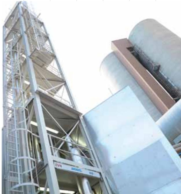
In der Versuchsanlage am kalorischen Kraftwerk Dürnröhr wird CO<sub>2</sub> gewonnen, gereinigt und verwendet.
