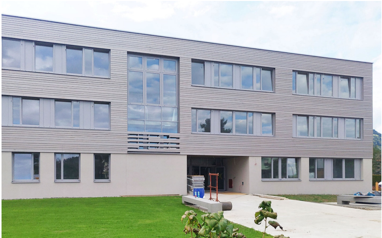
Ostansicht – Haupteingang. September 2021
