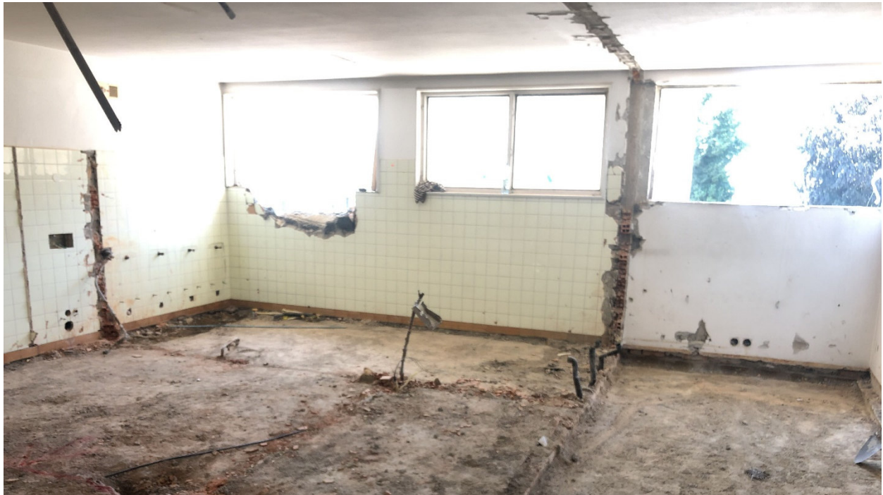
Abbrucharbeiten Innenbereich. Juli 2020
