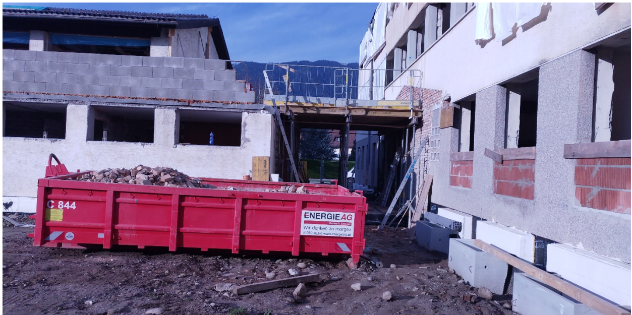
Rohbauarbeiten Westtrakt - Turnsaal. Oktober 2020
