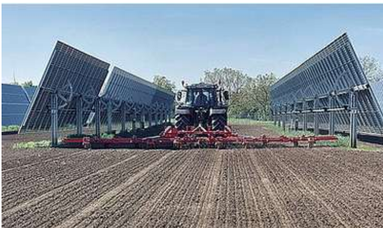
Die Bewirtschaftungsbreite zwischen den Modultischen werden an die landwirtschaftlichen Geräte auf einem Sonnenfeld angepasst. Im Bild sind die Module maximal aufgeklappt.
