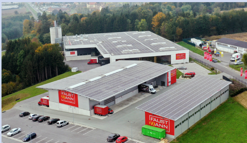
Sonnenkraftwerk Faustmann • Bild: Mein Kraftwerk
